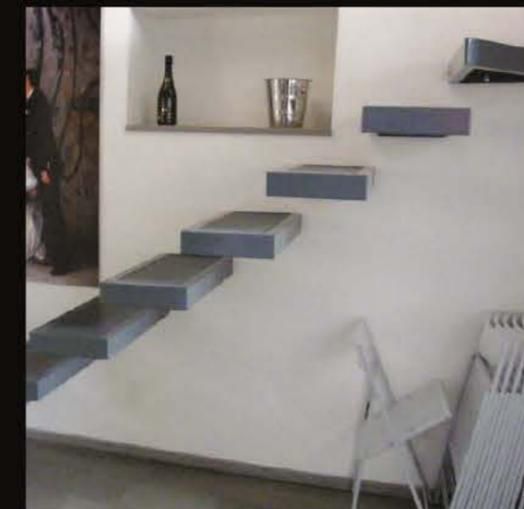
È uno degli elementi più interessanti che compongono questa ristrutturazione: una scala con gradini a sbalzo e parapetto soppalco realizzati con ferro e grata colorati in grigio color quarzite.
